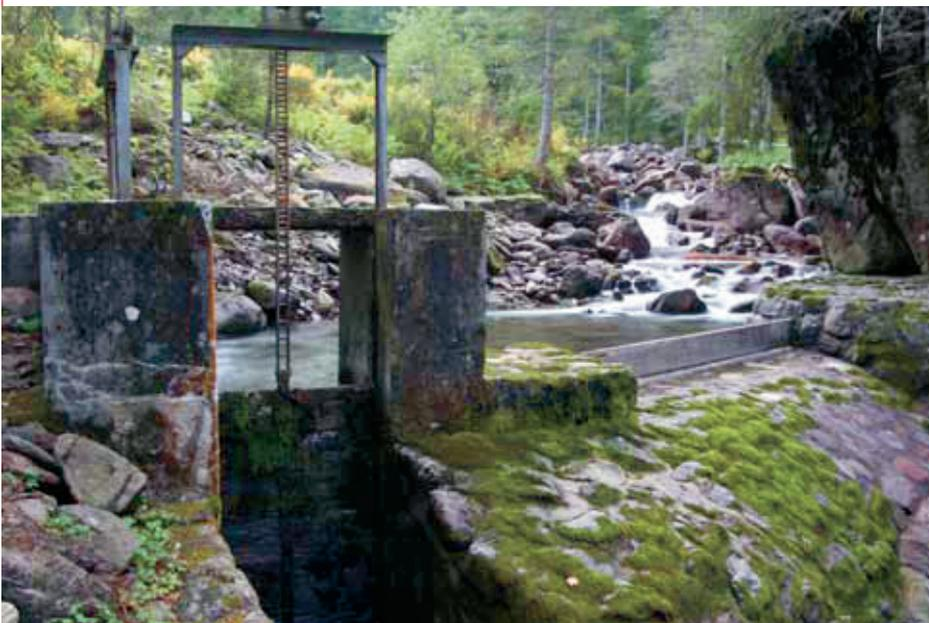
Seit 1950: Bei Bachlauri (Einzugsgebiet 17,7 km<sup>2</sup>) werden maximal 800 l/s Wasser des Murgbaches gefasst und in der Zentrale Merlen zur Energieerzeugung genutzt.
