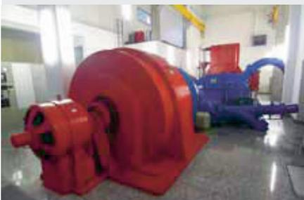
Stromproduktion mit 2 Pelton-Turbinen: Maschinengruppe Plätz II (vorne, 2080 kW) und Plätz I (hinten, 4200 kW).
