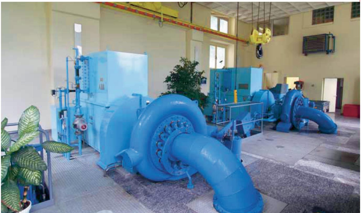
Kraftwerk Gödis: Stromproduktion mit zwei Francis-Turbinen (Leistung 2 x 1400 kW).
